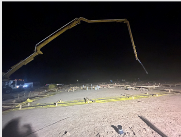
Grade beam concrete pour
