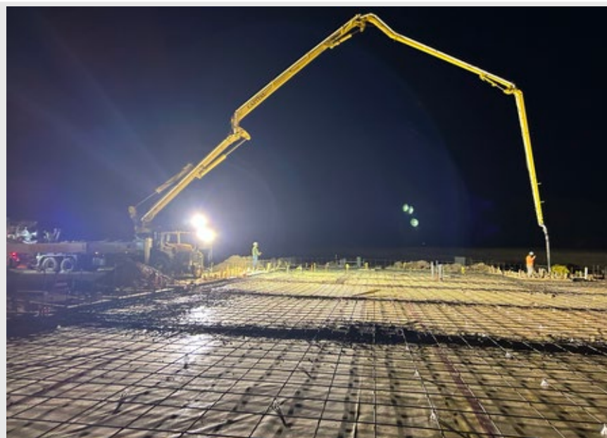
Cafeteria Concrete Pour
