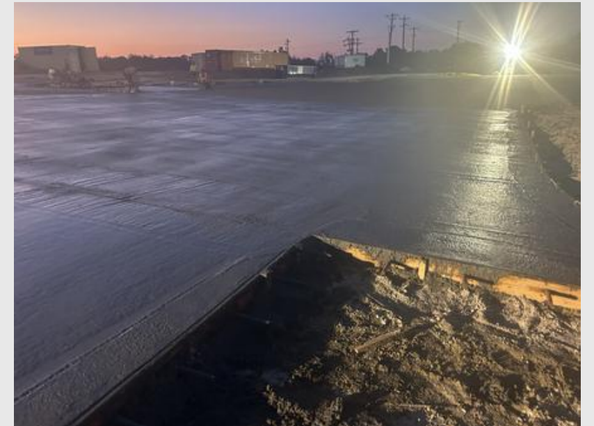
New ES- Paving Pour
